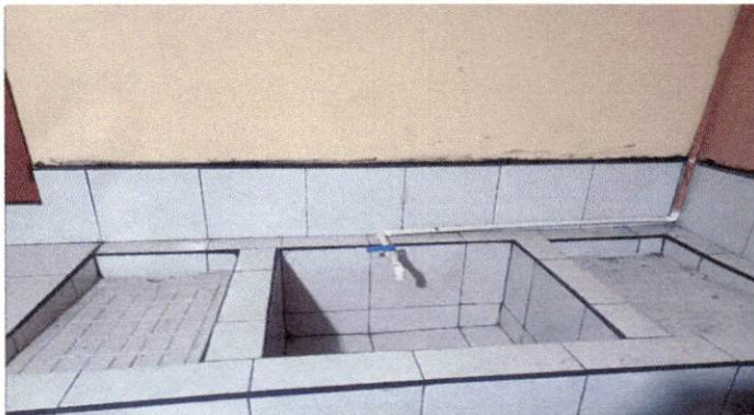
Foto 3: FINALIZACIÓN DE SUSTITUCIÓN DE PILA DE CEMENTO MÓDULO 2.
